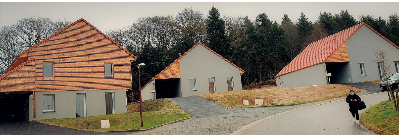
Construction de 6 pavillons à Saint-Vaury.
