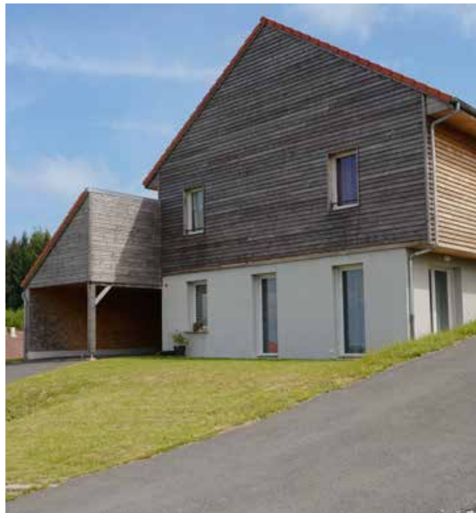
St-Vaury, 6 pavillons neufs mis en service en décembre 2021 ©Emmanuelle Trompille
