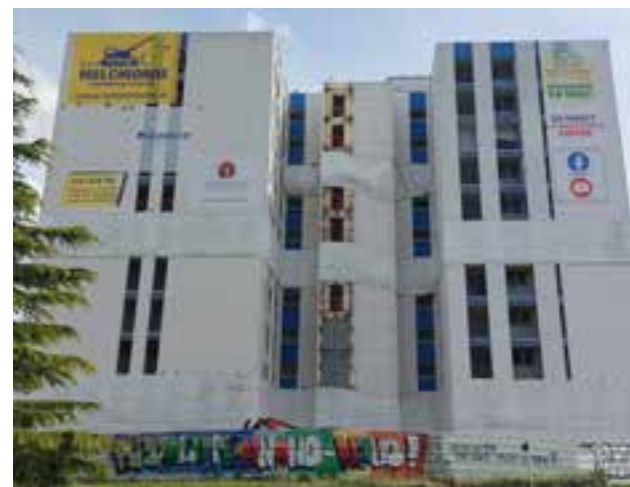
Guéret, 12 rue du Docteur Brésard, démolition prévue le 14 mai 2023 © Creusalis
